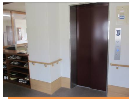
エレベーター
